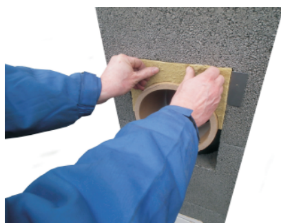
Vyjmeme 1/2 desky a dle průměru komínu upravíme nožem otvor v ní.
