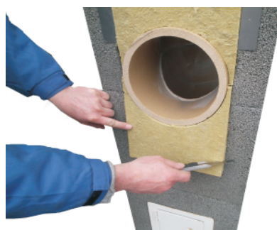
Poté výškově zkrátíme desku dle připraveného otvoru v tvárnici.
