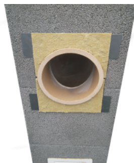
Osazená čelní deska připravená pro omítnutí.
