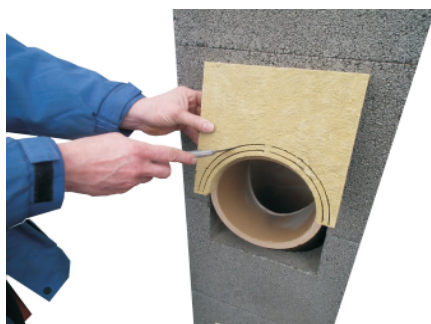
Vyjmeme 1/2 desky a dle průměru komínu upravíme nožem otvor v ní.
