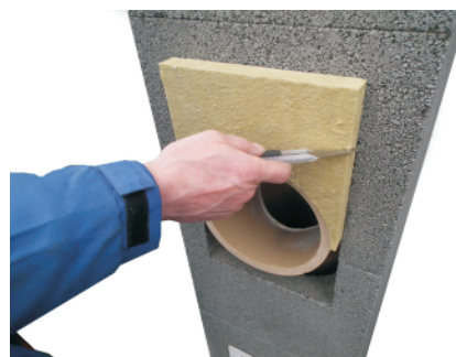
Poté výškově zkrátíme desku dle připraveného otvoru v tvárnici.
